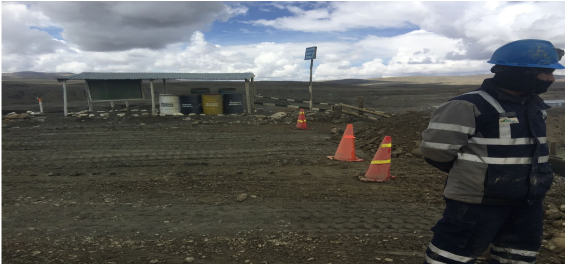
Anexo 9: Acopio temporal de residuos sólidos.
